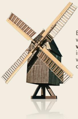
Eine frühe Form der Energiewende: Die drehbare **Bockwindmühle** kann komplett in jede Richtung gewendet werden und so die Windkraft optimal nutzen.
